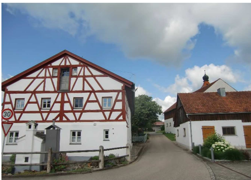
Abb. 13. Bestandsbebauung im Ortskern II + D
