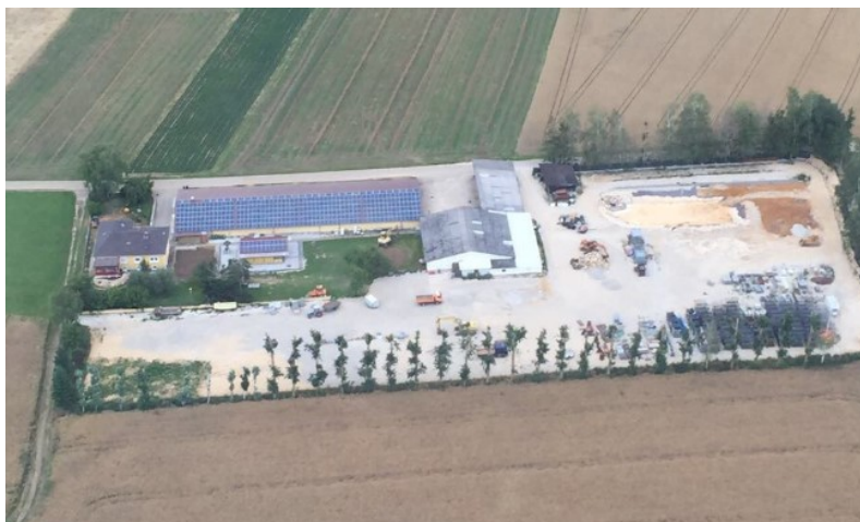
Abb.2 Luftbild mit der Darstellung des Ist Zustandes des Betriebes mit den Aussenanlagen
