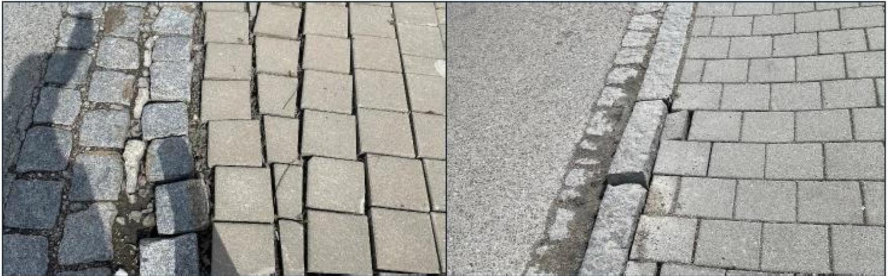
Abbildung 2: Entstandene Schäden an der Verkehrsinfrastruktur
