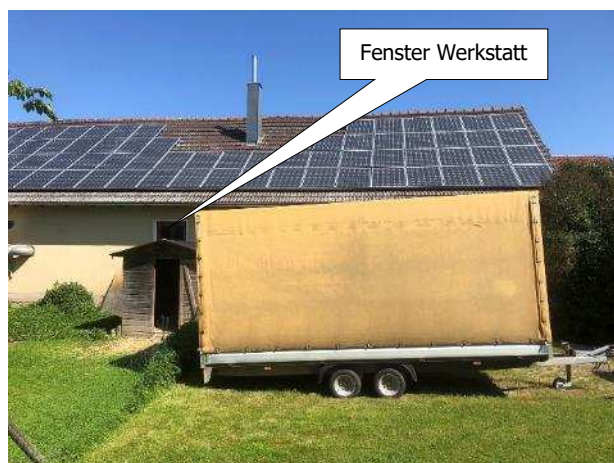
Bild 4: Blick Südseite (Werkstattbereich)
